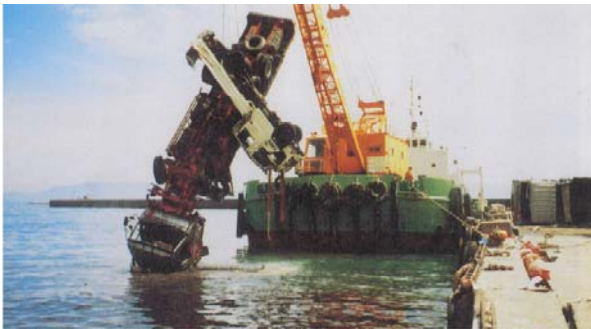
奥尻港内へ転落した車両の引上げ (北海道南西沖地震)
