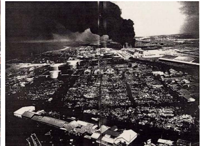
石油タンク火災 (新潟地震)
