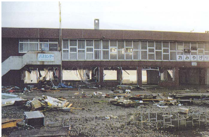
奥尻島フェリーターミナル施設の破損 (北海道南西沖地震)
