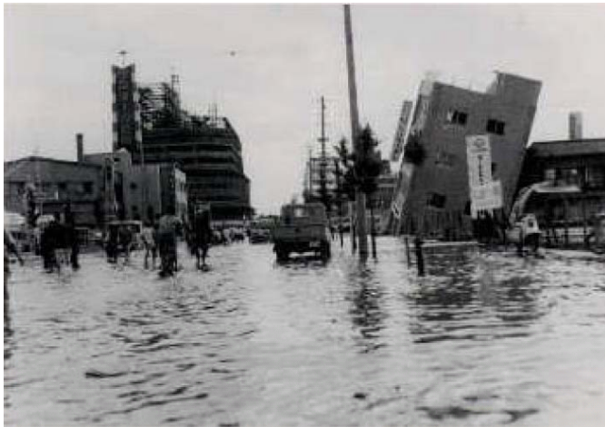
津波により60cm程度浸水した新潟市内 (新潟地震)
