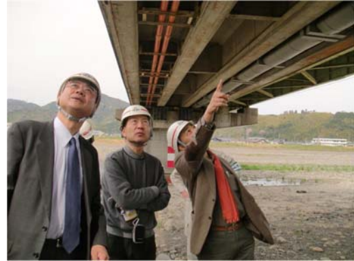
視察の状況（牧ヶ谷橋）
