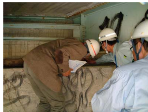
視察の状況（新橋）
