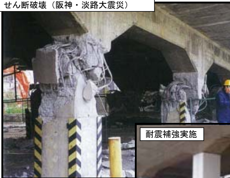
せん断破壊（阪神・淡路大震災）
