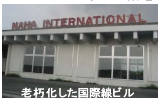
老朽化した国際線ビル
