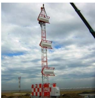
(老朽化した計器着陸装置の更新)
