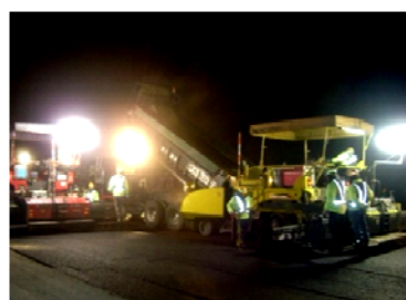
(老朽化した滑走路舗装の改良)
