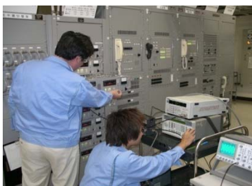
(航空保安施設点検実施状況)
