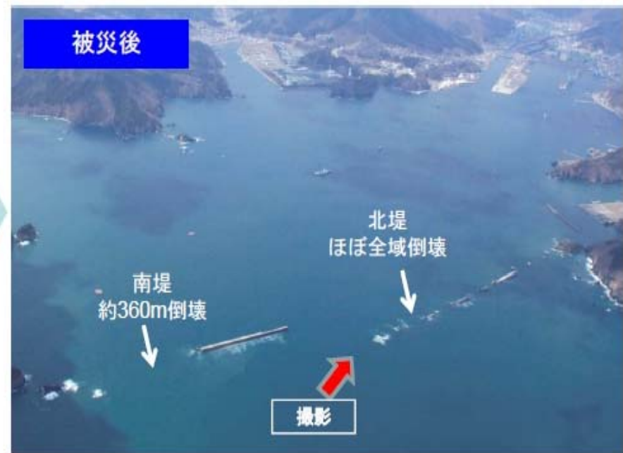
(撮影) 北堤の倒壊状況
