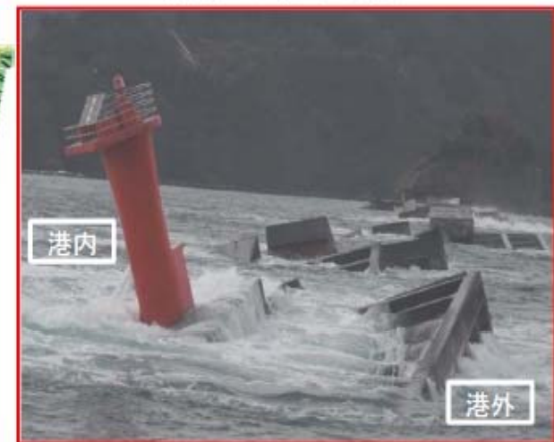
(撮影) 北堤の倒壊状況
