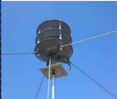
全方向型防災無線放送塔
