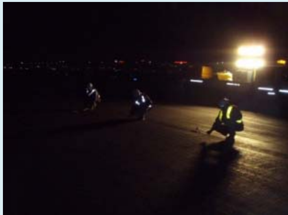
<打音点検状況>
