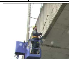
高架橋防音壁の点検の様子
