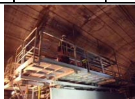
トンネル天井部の点検の様子
