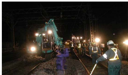
軌陸バックホウによるマクラギ交換
