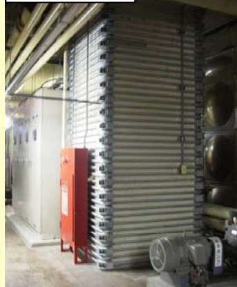
RB耐震補強工法
