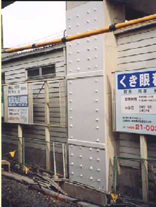
一面耐震補強工法
