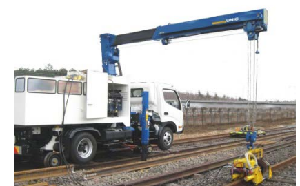
レール溶接軌陸車
