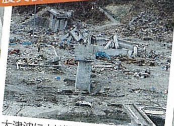
大津波により橋脚ごと破壊された島越駅(2011年4月撮影)
