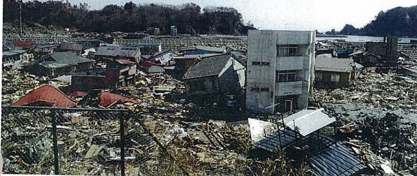
大津波が高さ10メートル、長さ2.4キロメートルに及ぶ大堤防を乗り越えた宮古市田老地区
