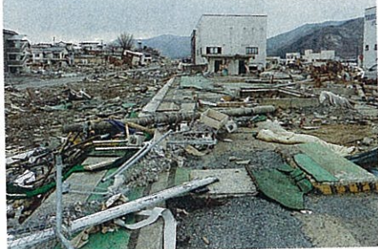
線路が流されがれきが散乱するJR大船渡線大船渡駅のホーム
