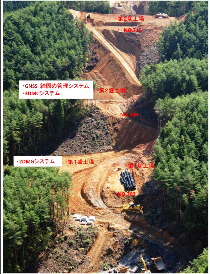
現場全景写真 起点側より
