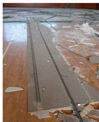
脱落した天井部材
