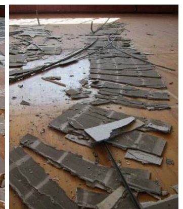
脱落した天井部材
