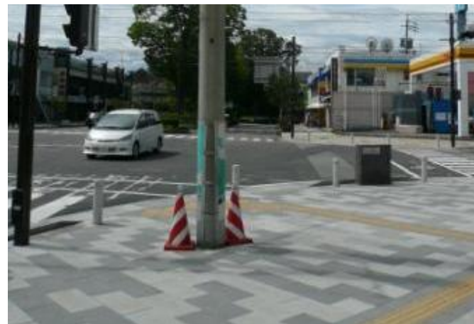
■バリアフリー化された道路に電柱が存在している例
