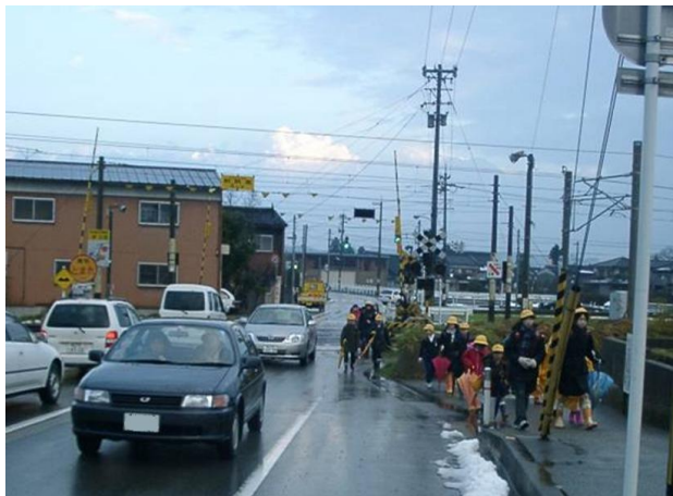
■踏切道で歩行空間が確保されていない例
