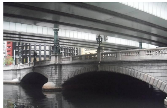
日本橋上空の首都高速道路
