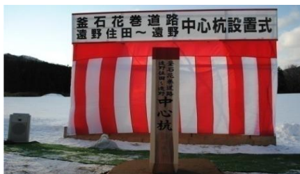
設置された中心杭(釜石花巻道路)
