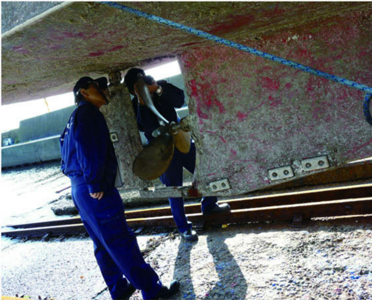
理事官による船体検査の様子。船底の損傷箇所を調べ、証拠写真を撮影していく。
