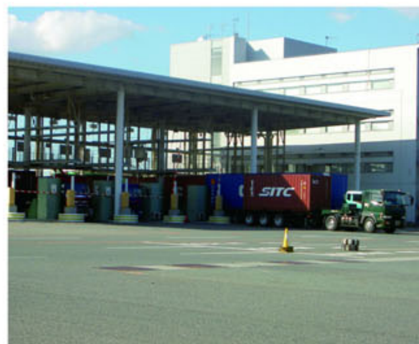
コンテナターミナルのゲート。各トラックはここで入場手続を済ませる。
