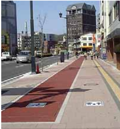
歩道における歩行者と自転車の 視覚的分離の整備事例
