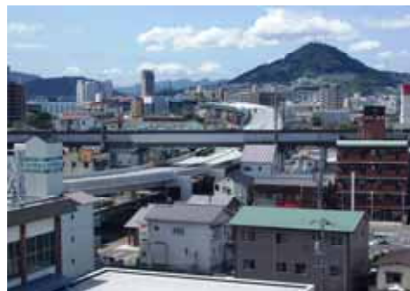
【整備事例(広島高速2号線)】
