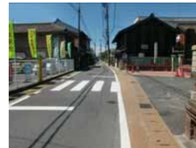
路肩をカラー舗装化した 東海道
