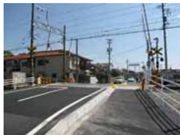
踏切が拡幅された市道日永東日野線
