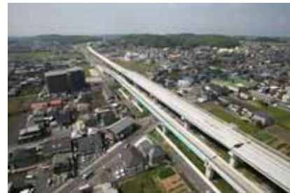
整備が進む北勢バイパス
