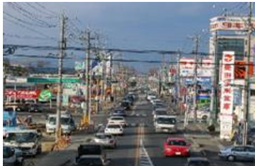
■電線・電柱が乱立
