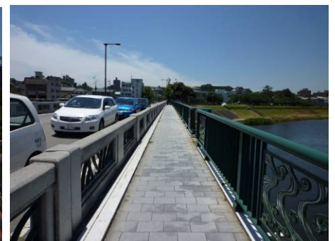
吹矢橋歩道設置現況
