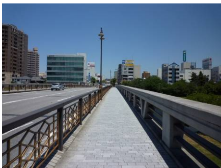
殿橋東側歩道設置現況
