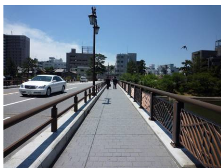
明代橋歩道設置現況
