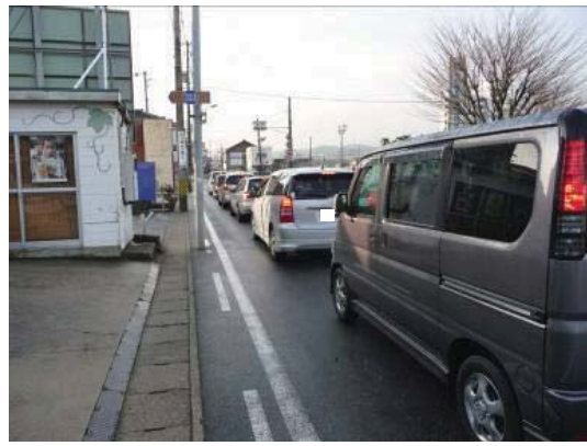
県道岡崎幸田線（(都) 芦谷高力線）の状況
