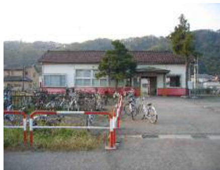
図 1-2-6 老朽化が見られる駅舎
