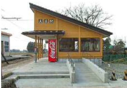
図 1-2-5 改修された大庄駅
