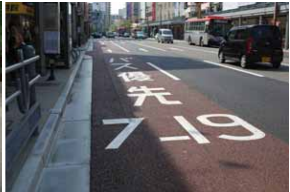
〔バス走行空間のカラー舗装事例(砦谷小路)〕
