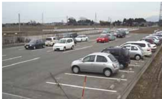
JR 磐越西駅 新関駅 P & R 駐車場
