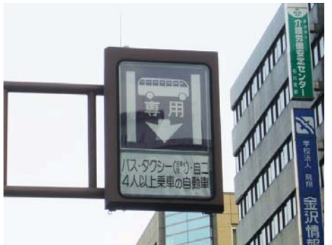
写真 1-2 HOVレーンに設置されている交通規制標識 (石川県金沢市 国道 157 号)
