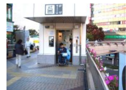
図4-20 エレベーターの設置
