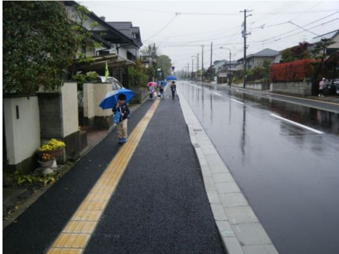
図4 - 36 団地内の歩道整備
