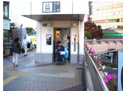
図4-4 駅舎へのエレベーターの設置
