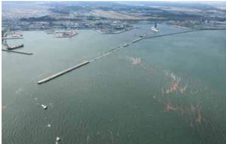
八太郎北防波堤の被災状況
