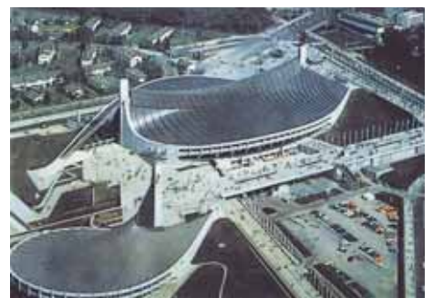
国立屋内総合競技場 (1964) National Indoor Stadium
