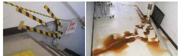
【防災拠点施設の被害】
