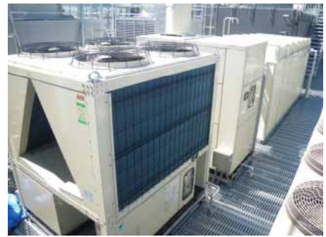
氷蓄熱ユニット Ice thermal storage unit
