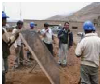
低コスト耐震住宅技術普及プロジェクトII（ペルー） Dissemination on Construction Technology for Low-Cost and Seismic Resistant Houses II (Peru)
