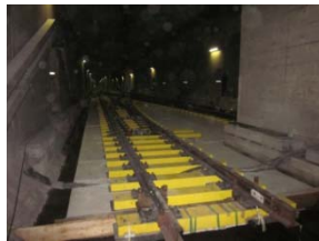
◀8番SC敷設(H23.4コンクリート打設)▶
