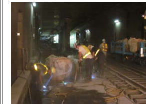
◀B線既設分岐器撤去(H23.8)▶
