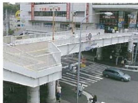
道路の付帯施設
