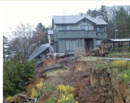
滑動崩落による被害状況（東日本大震災）
