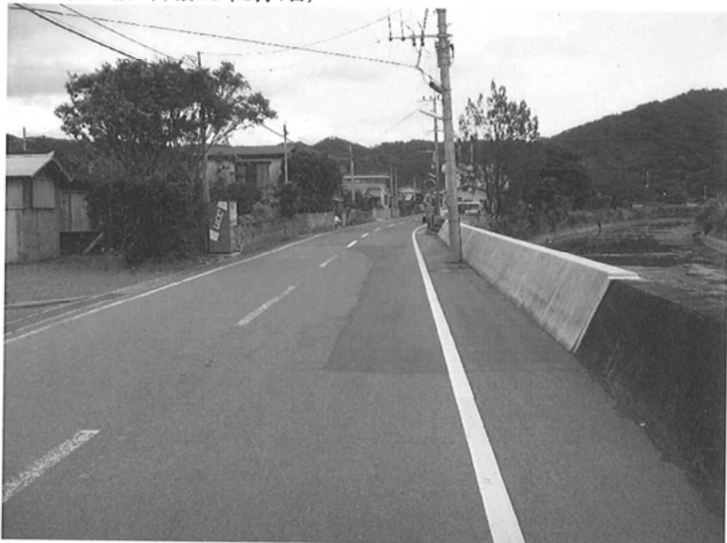
完成 (平成23年8月1日)
