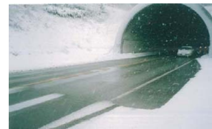
ロードヒーティング設備による融雪状況
