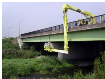
橋梁点検車を使った橋梁点検
