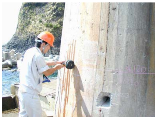
非破壊検査による橋脚内部の検査
