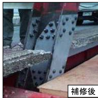
平成19年6月29日補修完了
