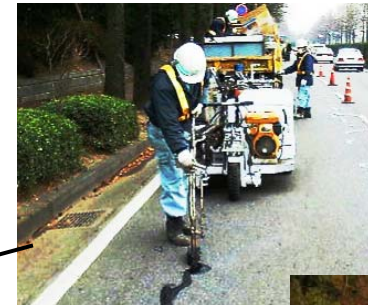
予防的修繕工法 (シール材注入)
