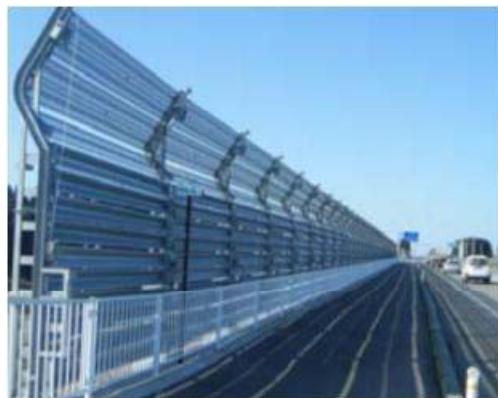
防雪柵存置の状況
