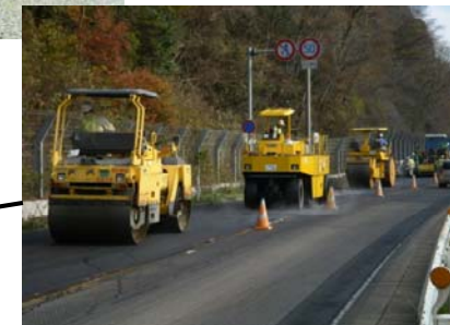
修繕工法 (切削オーバーレイ)
