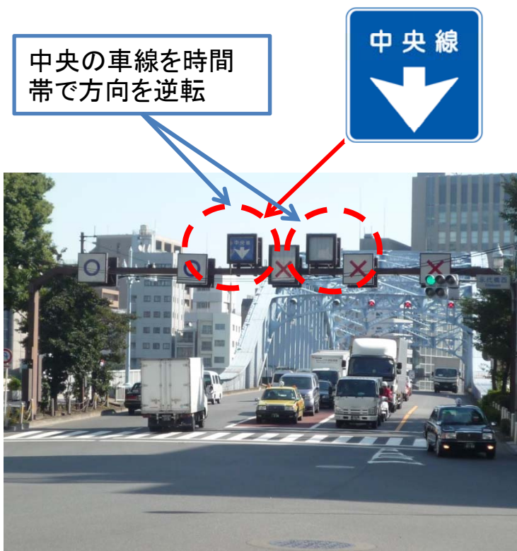
(東京都道10号 永代橋)
