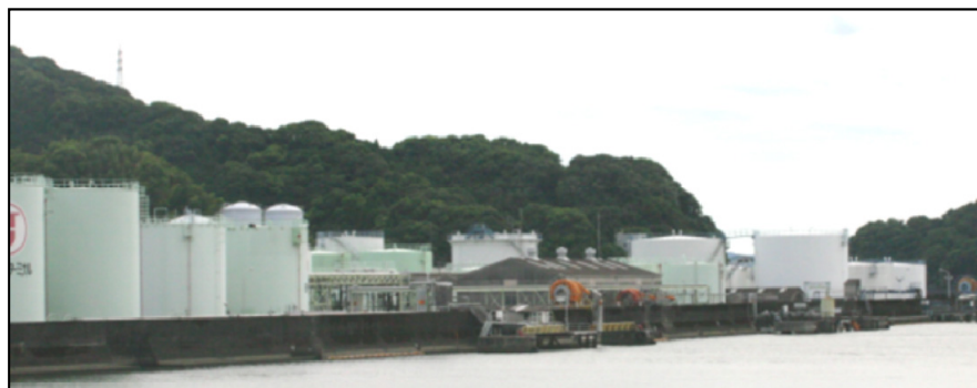
浸水区域内の石油備蓄基地
