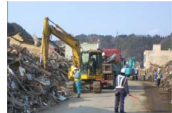
地元建設業による国道啓開作業(宮古市)
