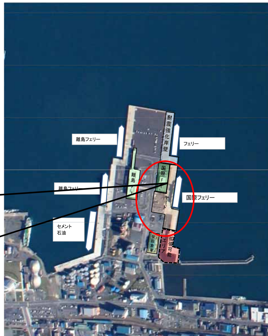
港湾施設の利用状況
