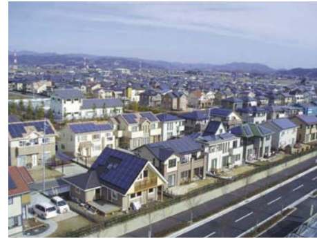
群馬県太田市における太陽光発電システム 実証試験地区 (PalTown 城西の杜)
