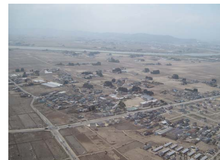
海岸からの距離がある程度保たれた自然堤防上の立地においては、大きな津波被害を受けていない。
