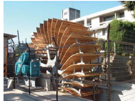
山梨県都留市における 家中川小水力市民発電所
