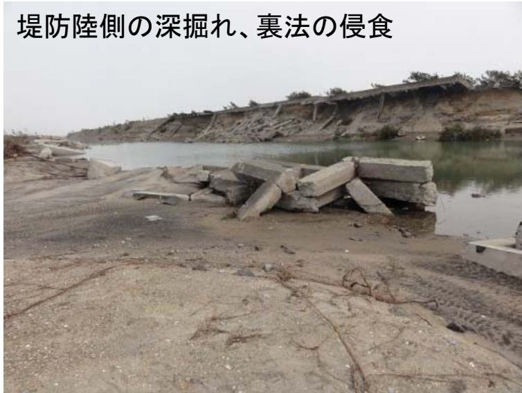
被覆工が陸側に流されている
