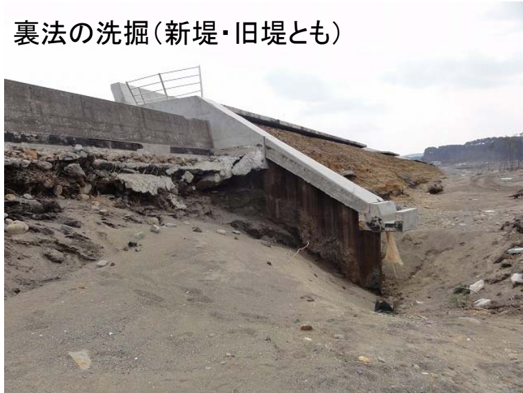
裏法の洗掘(新堤・旧堤とも)
