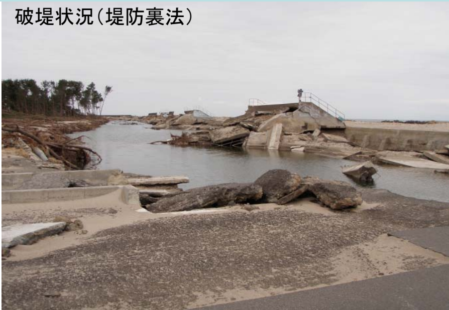
破堤状況(堤防縦断方向)
