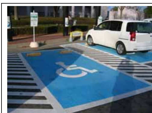
対象駐車スペースの青色の目立つ塗装 (福島県立医科大学付属病院)
