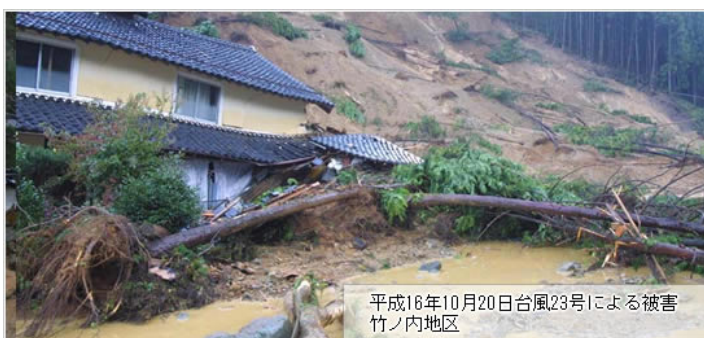
写真4 台風23号被害の状況（朝来市ホームページより）
