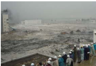
津波により浸水する下水処理場 (仙台市 南蒲生浄化センター)
