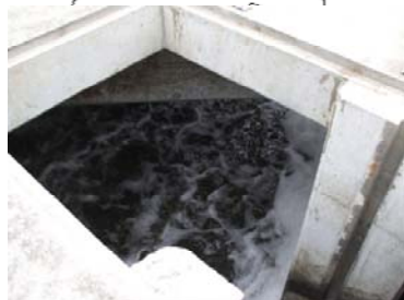
ほぼ通常の処理ができるまで復旧した処理場 左:処理槽の外観 右:曝気状況(福島県 新地町)
