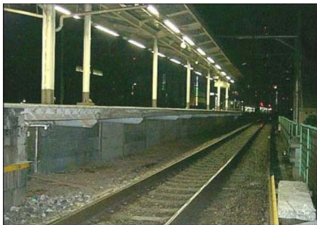
【ホーム下の待避スペース】
