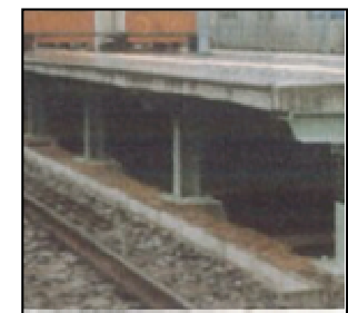
補強されたホーム
