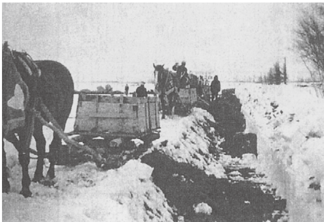
石狩平野(篠津地域)の泥炭地開発(排水路掘削)の様子(昭和30年代)
