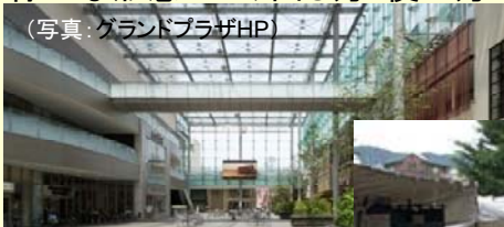
グランドプラザ(富山市) 市街地再開発事業による
