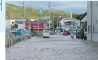
◀ 並行する国道55号 （路面冠水状況） 【安芸市赤野地先】
