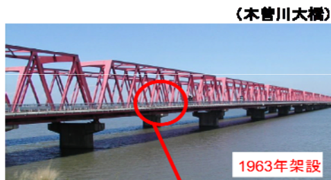
2007年6月にトラス橋の斜材が破断
