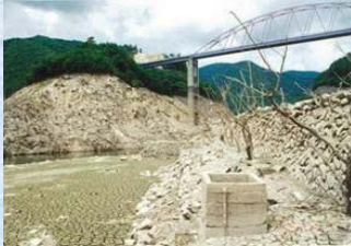
枯渇した岩屋ダム(水資源機構提供)
