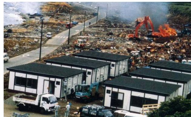
写真5 被災地区に設置された仮設住宅
