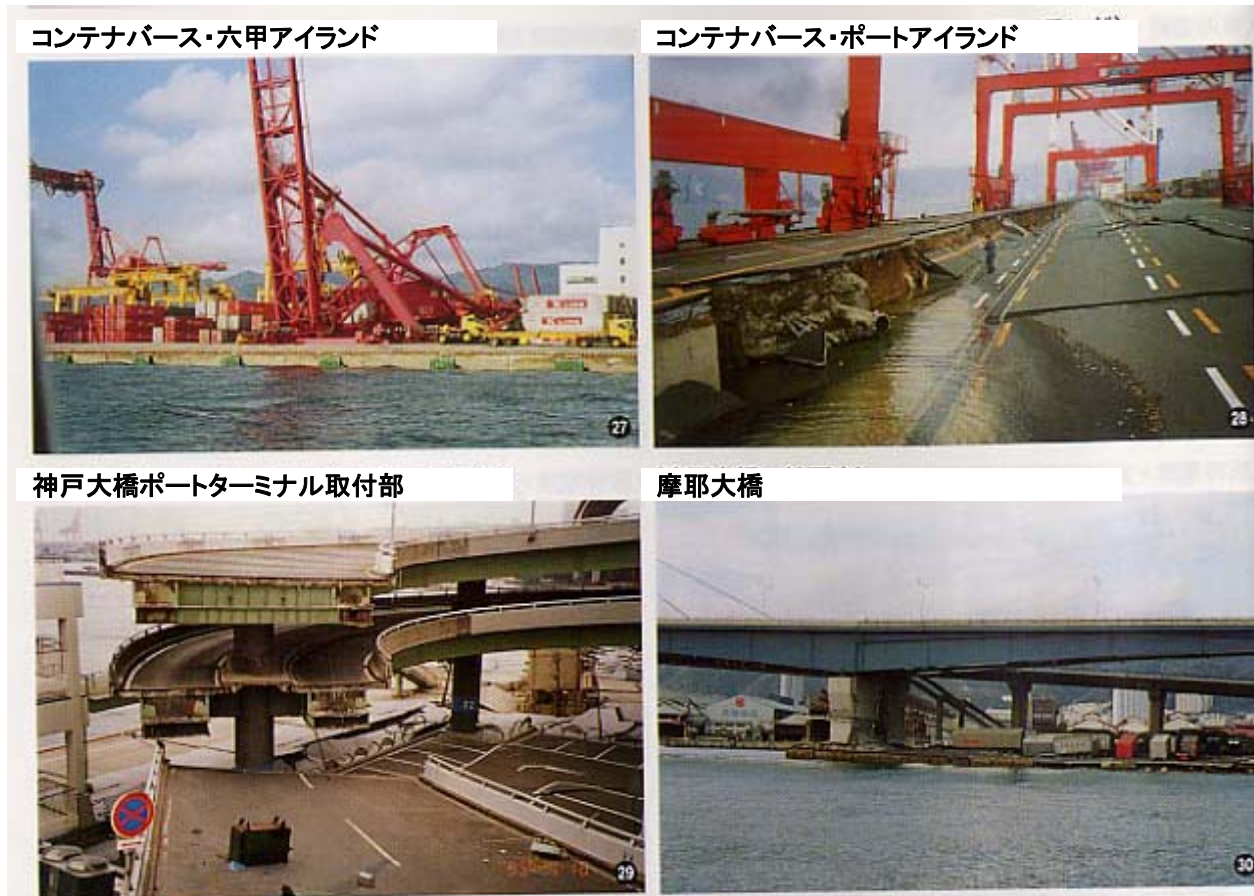
図1 コンテナバースや背後の臨港道路の被災
