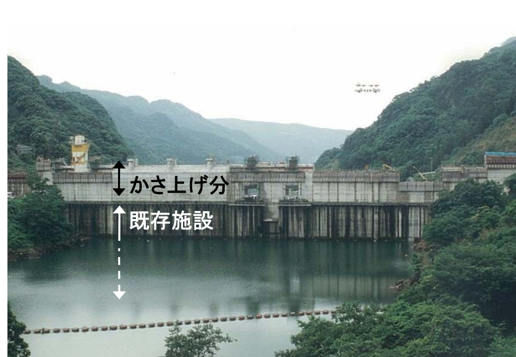
ダムかさ上げ
